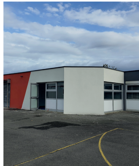
Rénovation de l'école de la Vallée
