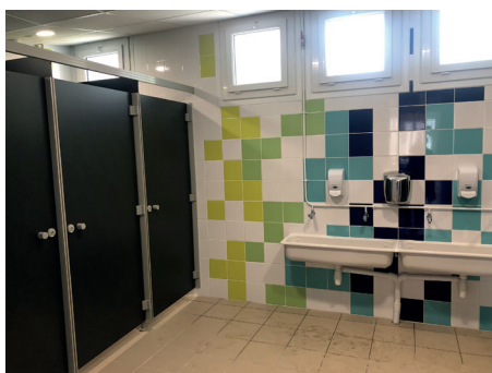
Les sanitaires rénovés
