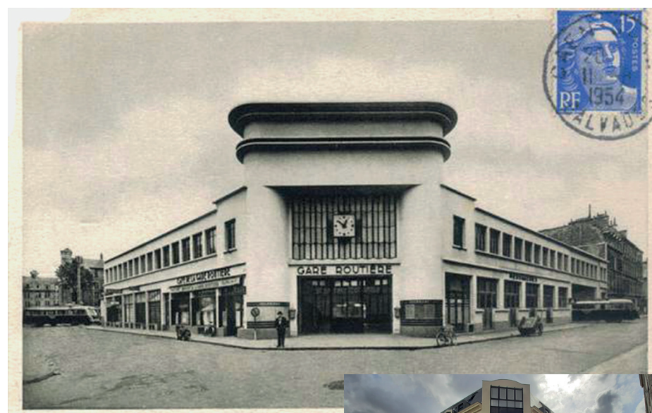
CAEN - La Gare routière
