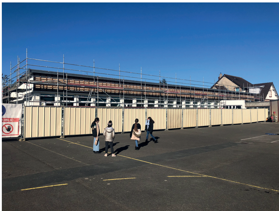
La protection du chantier de l'école de la Vallée
