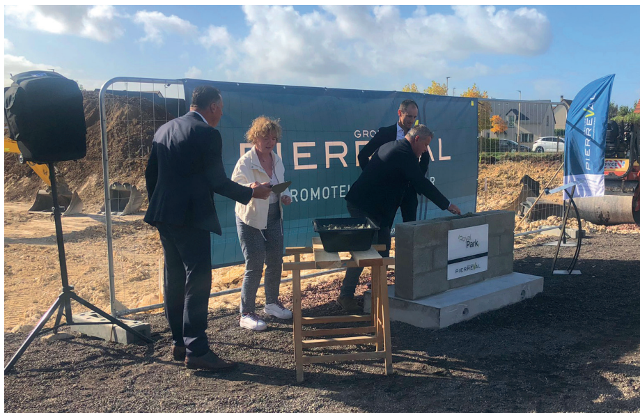
Pose de la Première pierre - 6 octobre 2022
