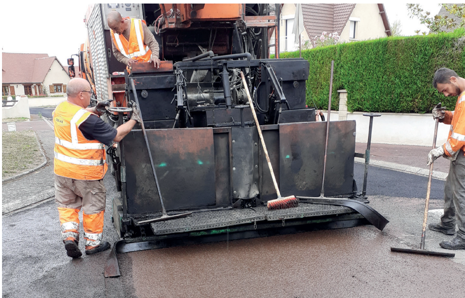
Travaux rue des Ormes - Septembre 2022
